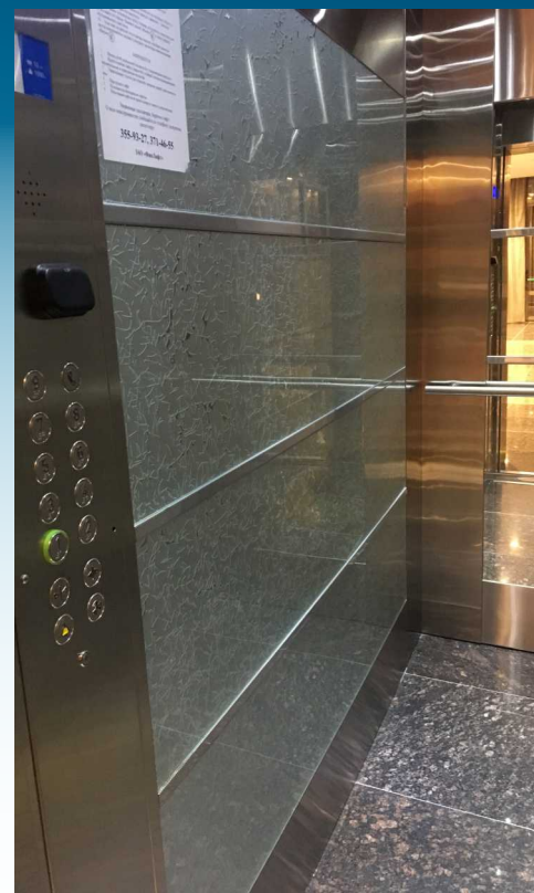
Свердловская обл., г.Екатеринбург, Гостиница «ТЕНЕТ» ул.Хохрякова,
